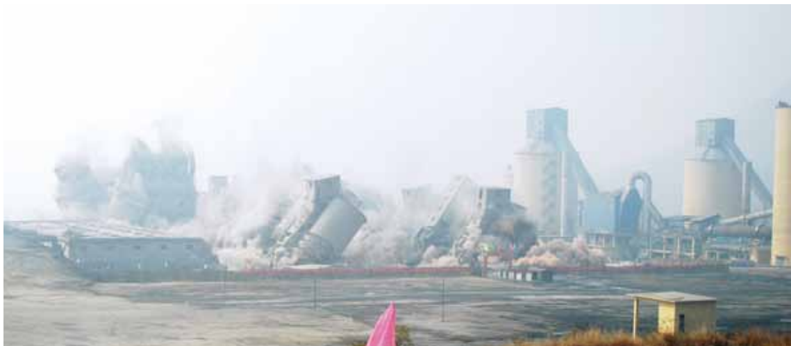
集中爆破9条立窑水泥生产线，被称为“中国水泥第一爆”
